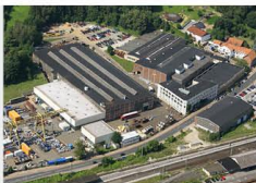
Alfeld Deutschland Asphalt-Mischanlagen
