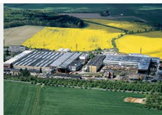
Nové Město Tschechien Schwere Walzen
